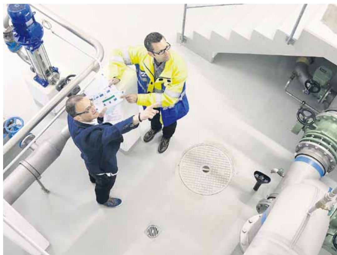
Kontrolle der Anlagen des Wasserreservoirs Buchwald.
