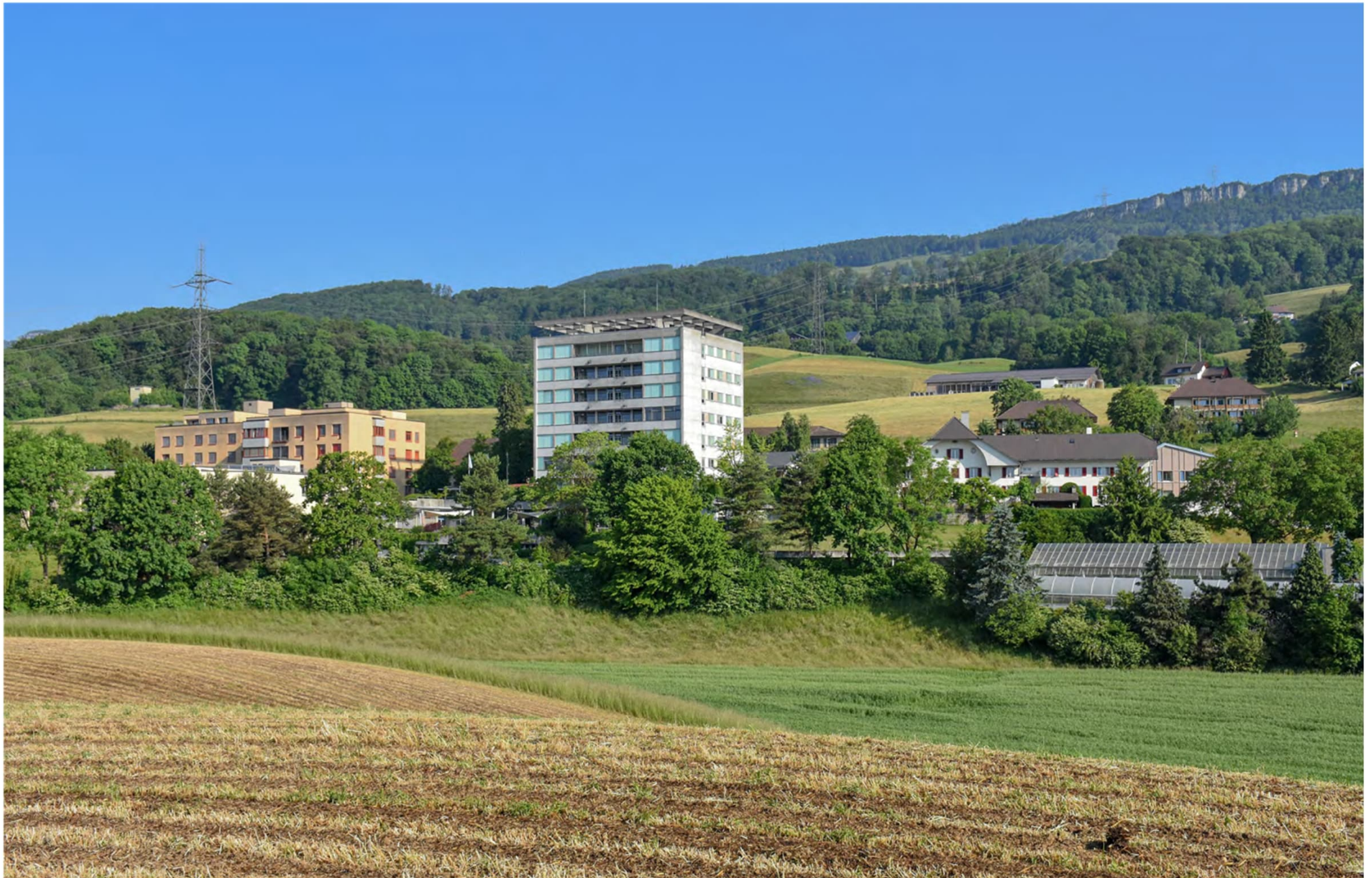
Juradorf, 2. Etappe Sanierung Panoramablick
